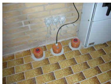
niveaumåler rentvandstank
