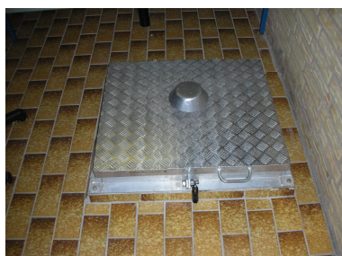
Nedgang til rentvandstank
