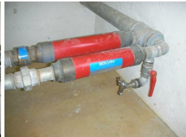
Magnetbehandling Prøvehane
