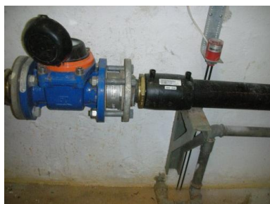
Hovedmåler Skal sidde efter hydrofor!
