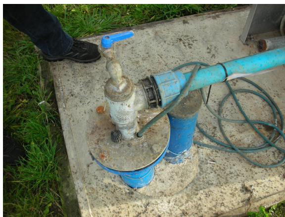
Flangekobling. Mangler diverse ting til tilstands kontrol.
