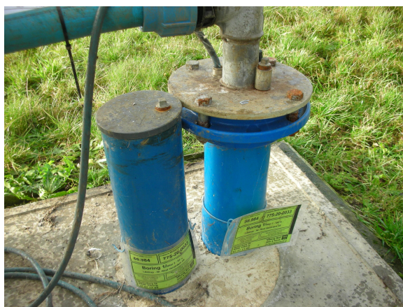
Flangekobling. Mangler diverse ting til tilstands kontrol.
