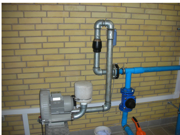
Kapselblæser med kontraventil. Måler til skyllevand
