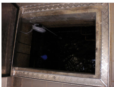
Rentvandstank vand- værk
